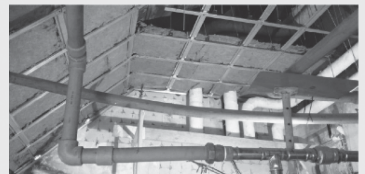
Proceso de ejecución de Aislamiento Acústico en Sala de Calderas Fuente: AYALA AISLAMIENTOS, S.L.
